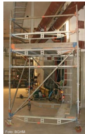
Modulgerüstbauteile
